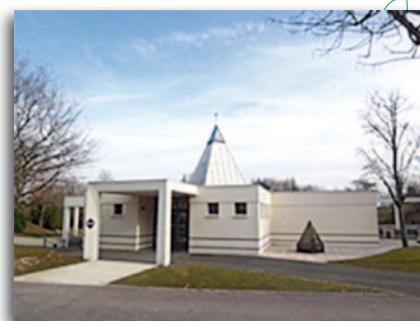
Crématorium des Ulis.
